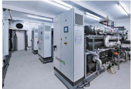
ヒートポンプは、既存のアンモニア冷凍機、石油冷却型空気圧縮機、それに熱源として使われているファンコイルユニットの排熱を使っていて。このことから熱はヒートポンプ蒸発器に接続している排熱貯蔵容器内に集められている。クローズド排水循環ループであるために腐食を避けるための特別な対策は必要としない。
