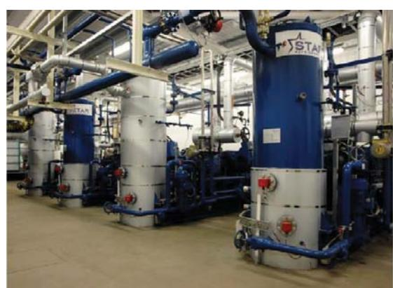
このプロジェクトは Nestle によるもので、加熱費用を年間 143,000 ポンド（166,000 ユーロ）節約し、スター冷凍機製アンモニア冷媒ヒートポンプを使って 120,000kg の炭素排出量を削減できることが分かった。加熱と冷却の両方を兼ね備えた新冷凍プラントにも係わらず、以前の冷却だけのプラントに比べて電気料金を年間 120,000 ポンド（140,000 ユーロ）も節約できる。このプロジェクトの別の効果として、水消費量を 52,000m<sup>3</sup>/日から 34,000m<sup>3</sup>/日にまで削減することができた。
